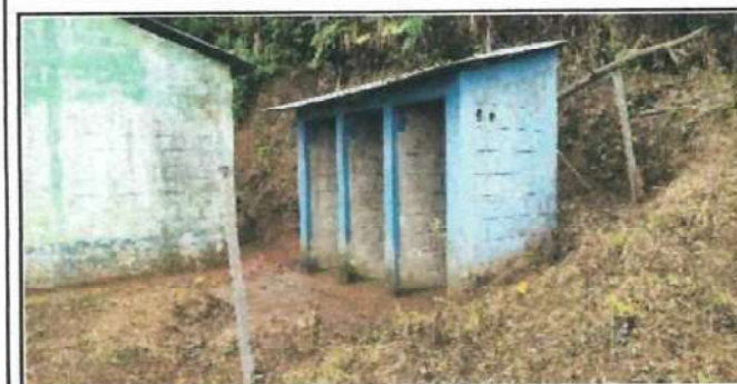
Foto 5: Se observa canales en mal estado, del establecimiento, y pinturas desgastadas en todos los módulos.
