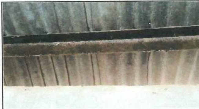
Foto 2: Sustitución de estructura de techo del baño.
