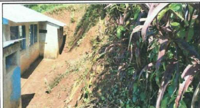
Foto 1: Se observa donde se colocará el muro perimetral por ese derrumbe.
